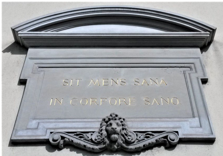
Spruch an der abgerissenen Sporthalle beim Kunsthaus ©AB
